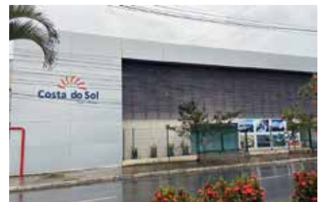
Fachada da sede Costa do Sol
